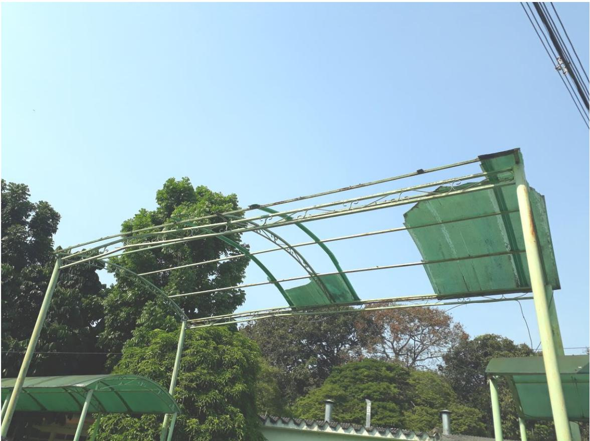
**Imagem 03** – Coberturas de policarbonato deterioradas.
