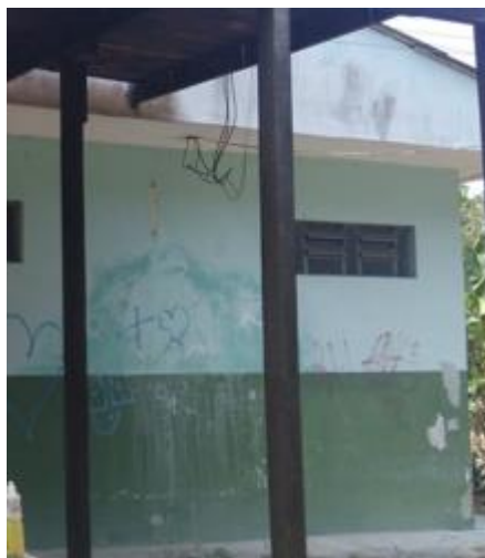
Figura 05. Paredes rabiscadas e fiação elétrica exposta
