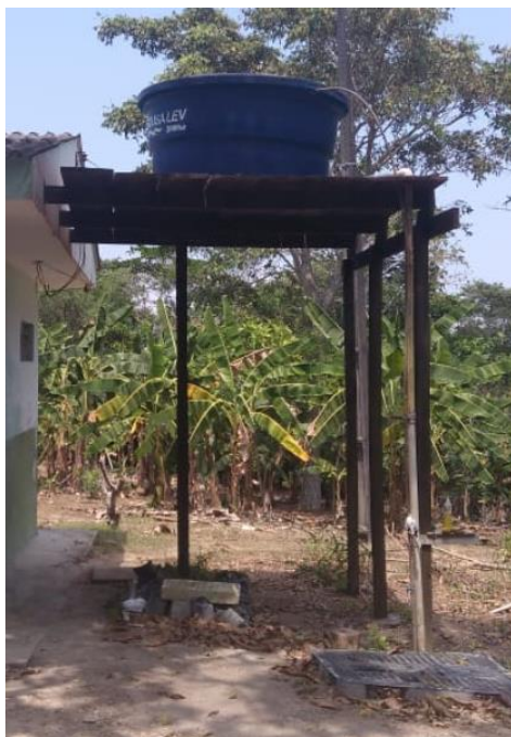
Figura 03. Estrutura inadequada para uso do reservatório de água.
