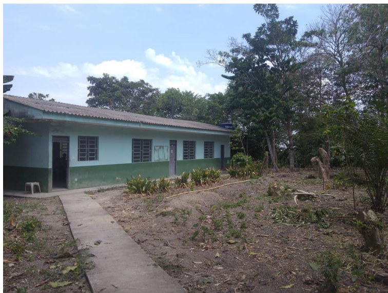
Figura 06. Visão geral da edificação com espaço para ampliação e necessidade de adequações para entrada, estacionamento, revisão do telhado etc.
