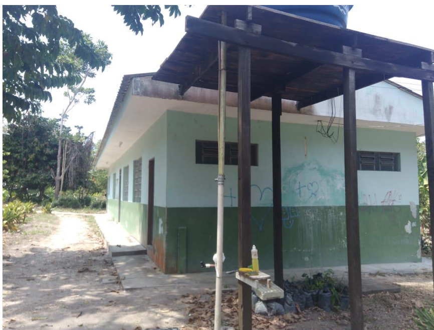
Figura 04. Lado sul da edificação
