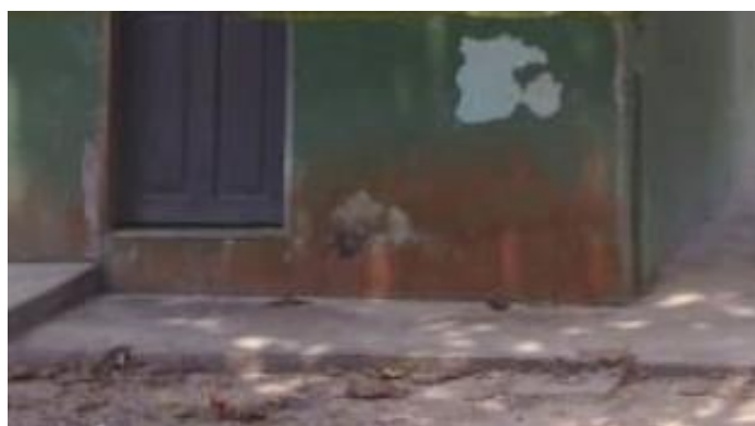
Figura 02. Manchas e descascamento na parede.
