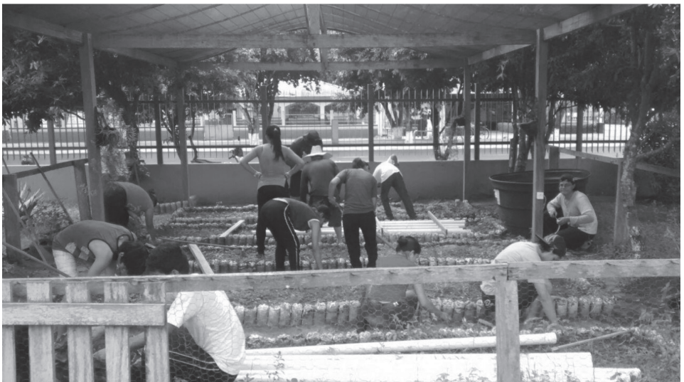
Figura 5 – Preparação da área para a montagem do sistema aquapônico na escola
