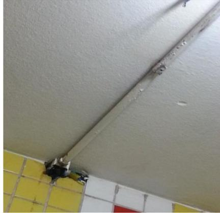
Foto 02: Armação da bancada principal da cantina, com placas de granito, cedendo.
