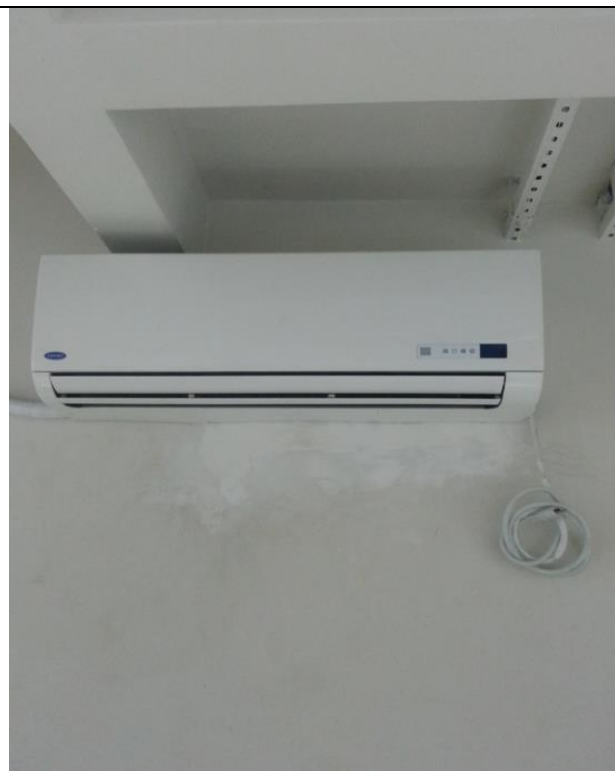
Foto 14: Ar condicionado não utilizado por ausência de tomada com tensão compatível.
