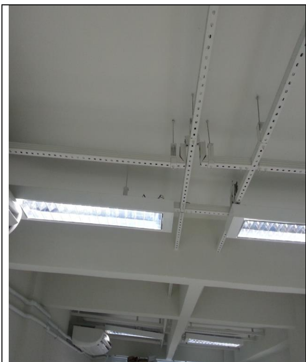
Foto 19: Luminárias fixadas dentro de nichos.
