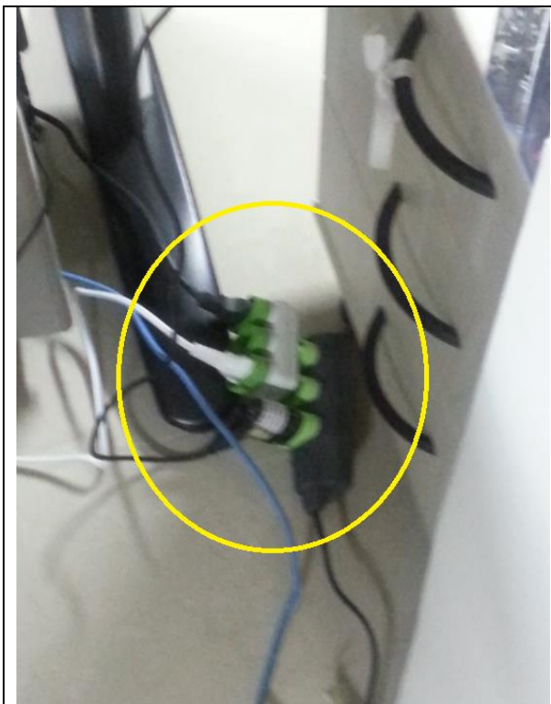
Foto 13: Sobrecarga de tomadas na extensão.
