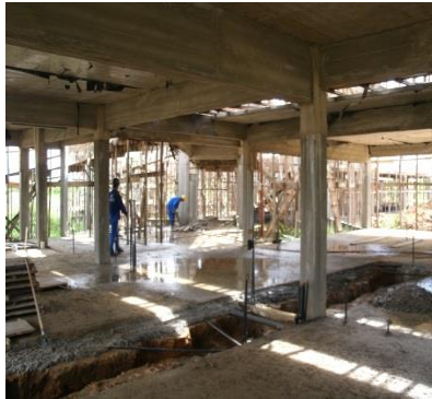
Figura 3 – Visão Parcial da Obra
