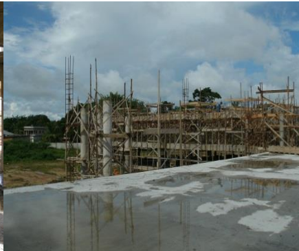
Figura 4 - Visão Parcial da Obra
