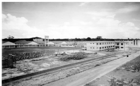
Figura 2: vista área da construção da Escola Técnica Federal de Manaus em 1941, na antiga Praça Rio Branco.
