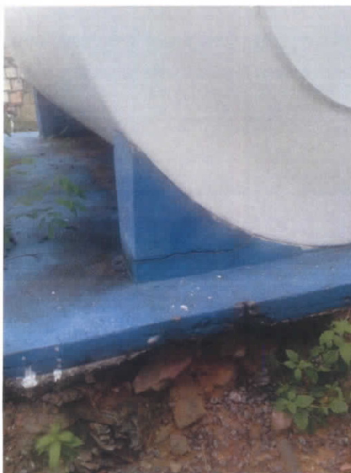
FOTOGRAFIA 6 - Vista do suporte de concreto armado que apoia a estrutura da Estação de Tratamento de Esgoto.
