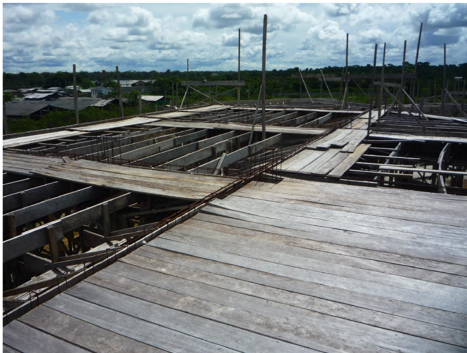
Foto 13 – Vista da cobertura do HALL.
