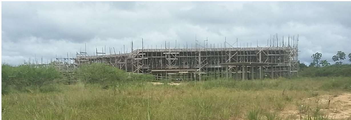
Foto 01 – Vista geral da edificação.
