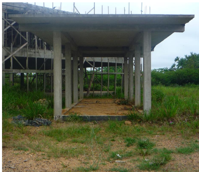
Foto 18 – Vista da SUBESTAÇÃO.
