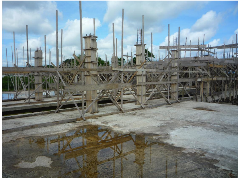
Foto 09 – Vista da ASA ESQUERDA.
