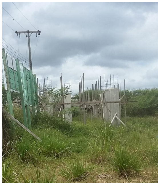
Foto 16 – Vista dos pilares construídos na GUARITA.
