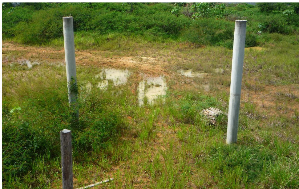
Foto 14 – Vista dos pilares do centro de CONVIVÊNCIA.
