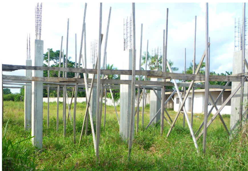
Foto 17 – Vista dos pilares construídos na GUARITA.
