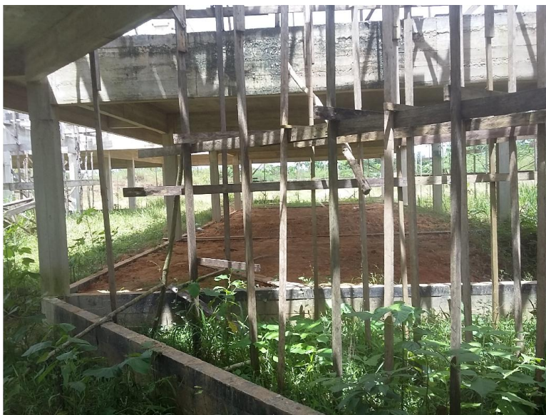
Foto 02 – Vista da ASA ESQUERDA.
