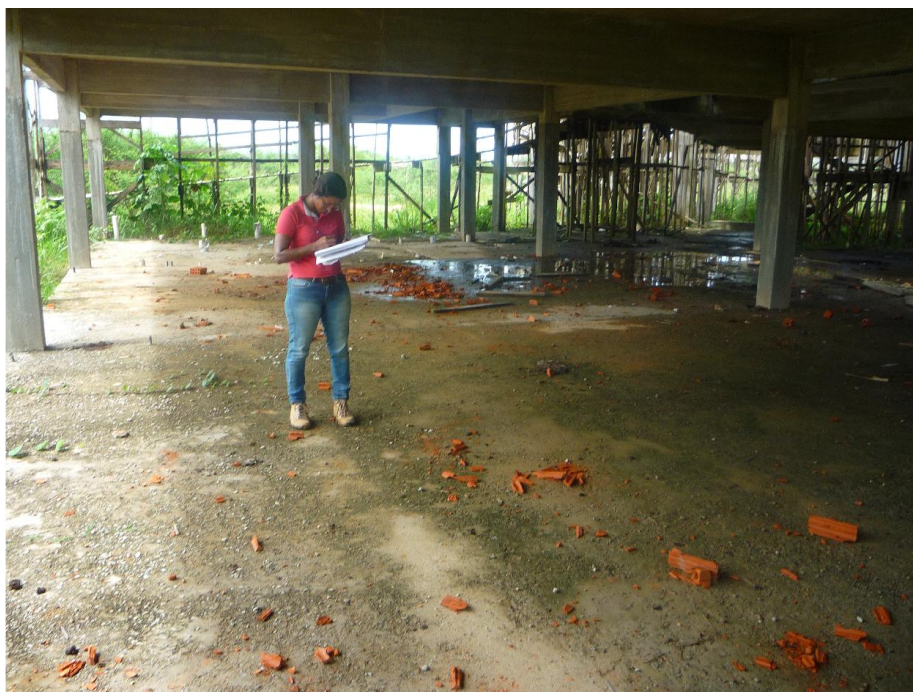
Foto 05 – Vista da ASA DIREITA do pavimento térreo.
