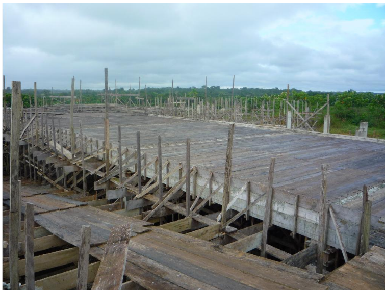
Foto 11 – Vista da cobertura da ASA DIREITA.
