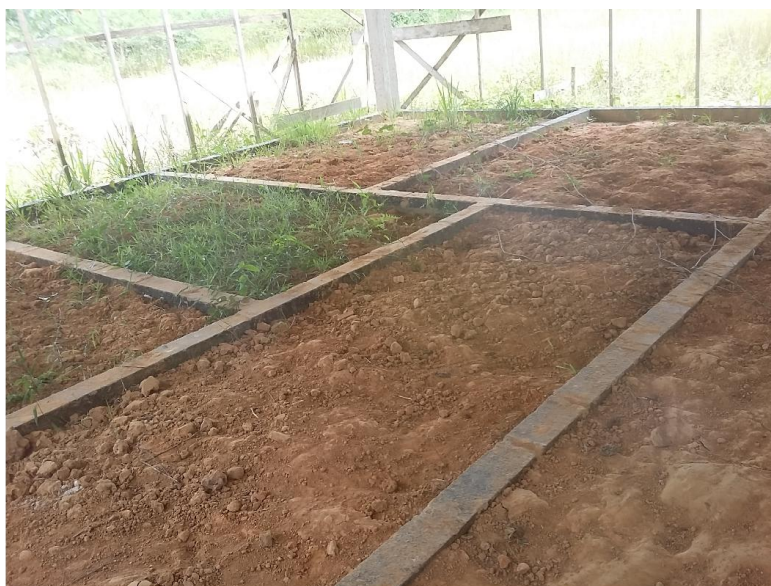
Foto 03 – Vista de parte do aterro executado na ASA ESQUERDA.
