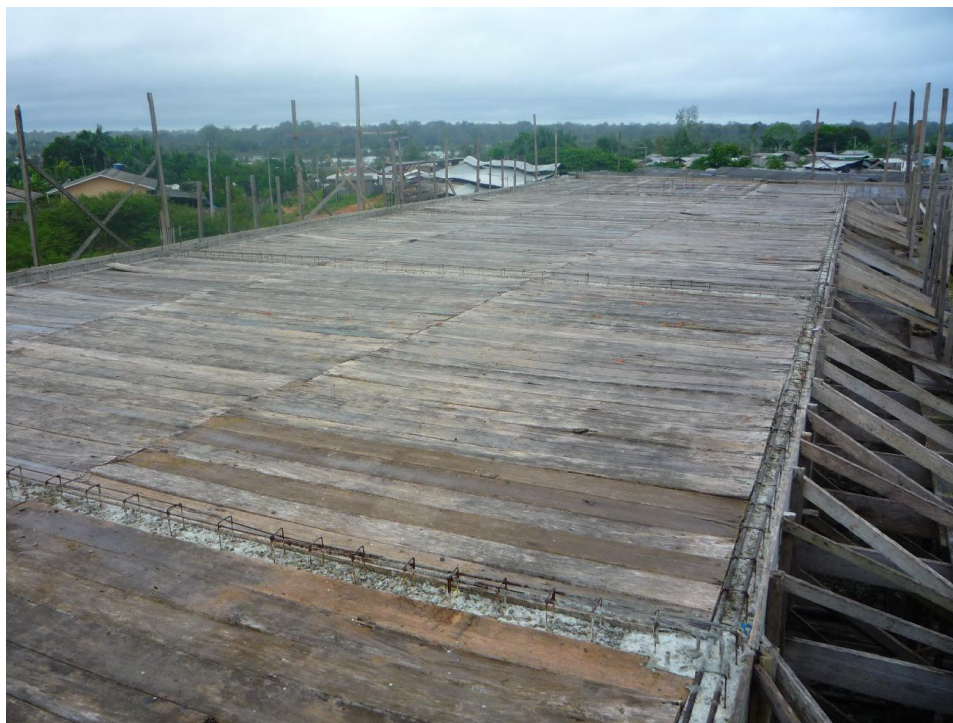
Foto 10 – Vista da cobertura da ASA DIREITA.
