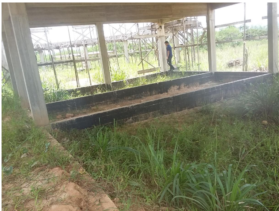
Foto 04 – Vista da parte onde não foi executado aterro na ASA ESQUERDA.
