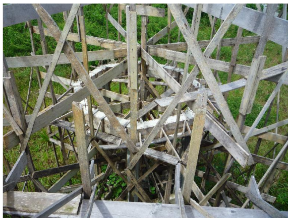
Foto 15 – Vista do CASTELO D’ÁGUA concretado até a cinta 2.
