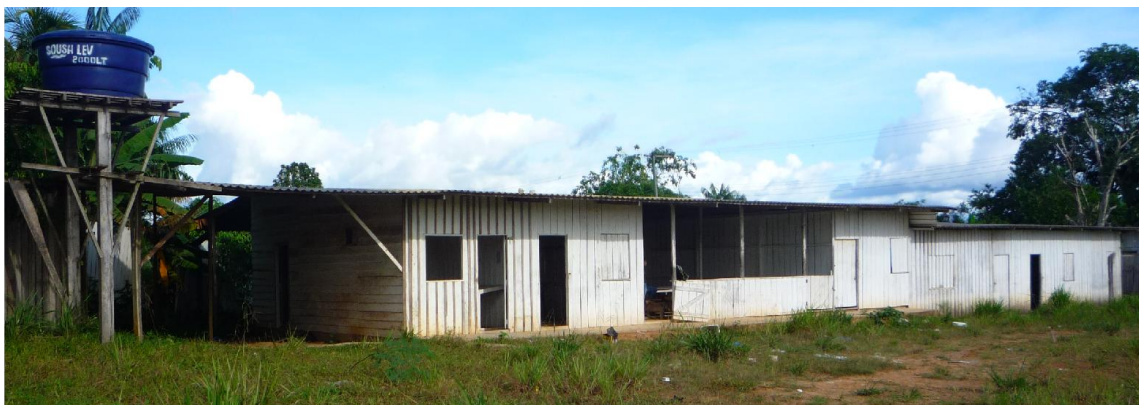
Foto 19 – Vista geral do BARRACÃO DE OBRA.
