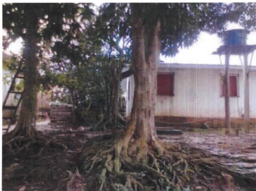
Fotografia 5 – Vista dos fundos do Campus, com a necessidade de remoção de árvores.
