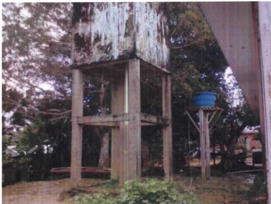
Fotografia 2 – Vista dos fundos da edificação. Nesta área será executada a ampliação da edificação, devendo ser removido o reservatório de concreto armado e o de fibra de vidro.
