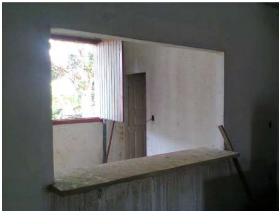
Fotografia 12 – Vista de parede a ser demolida na reforma da edificação.
