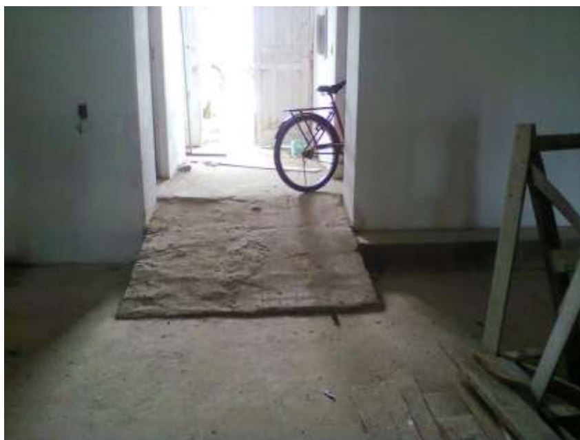
Fotografia 13 – Vista do acesso do futuro corredor, após a reforma.
