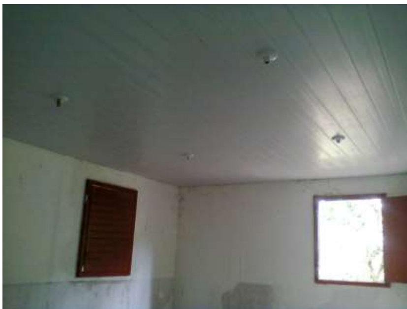
Fotografia 14 – Vista do forro existente na edificação. Considerado em bom estado pode ser reutilizado após a reforma.
