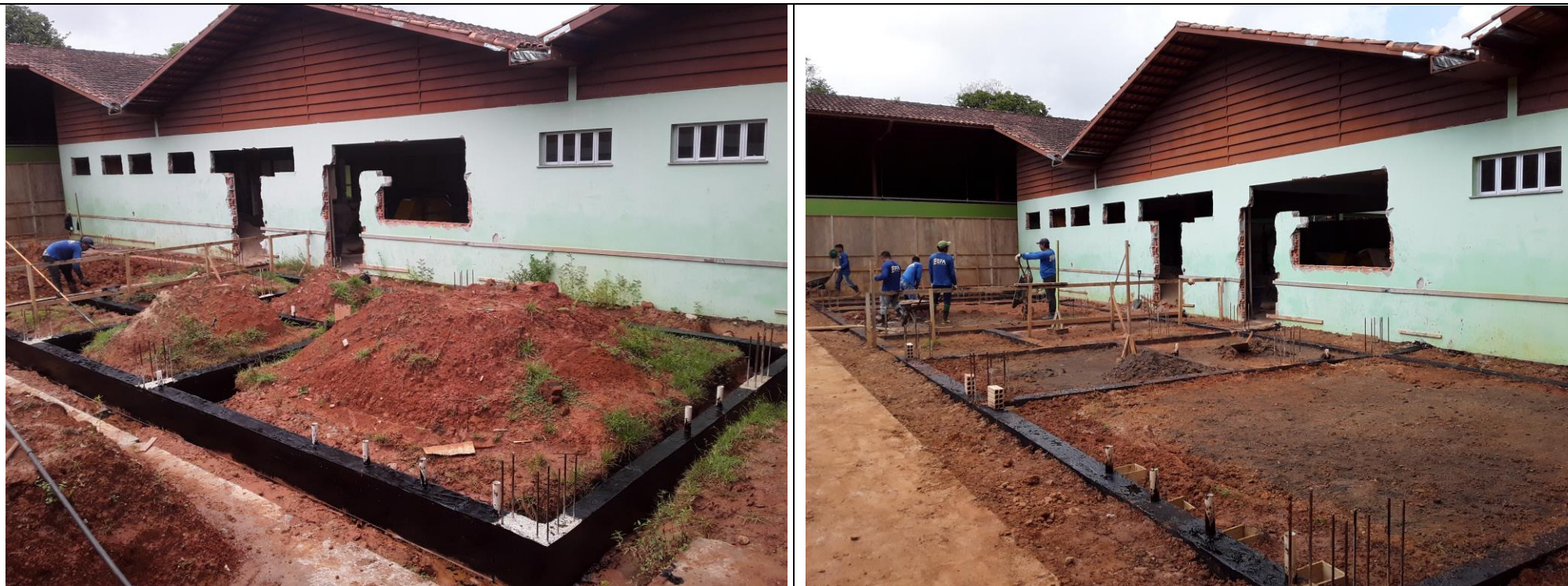
Imagens 64, 65 – Fundação, Impermeabilização das Vigas Baldrame e Re - aterro de Vala com Compactação Manual das Vigas Baldrame.
