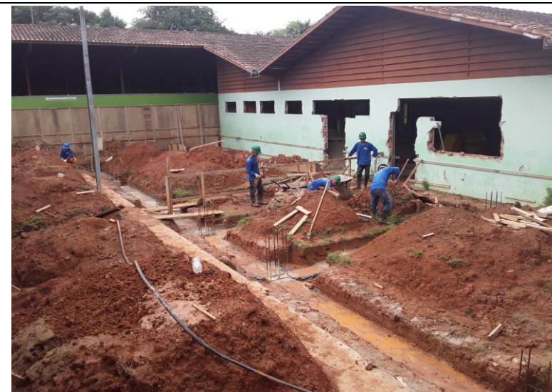
Imagens 39, 40, 41 – Fundação, Escavação das sapatas e Vigas baldrame, Forma das Sapatas, Concreto Magro, Locação das Ferragens das Sapatas e Arranques dos Pilares, Concretagem das Sapatas, Desforma e Compactação das Sapatas.
