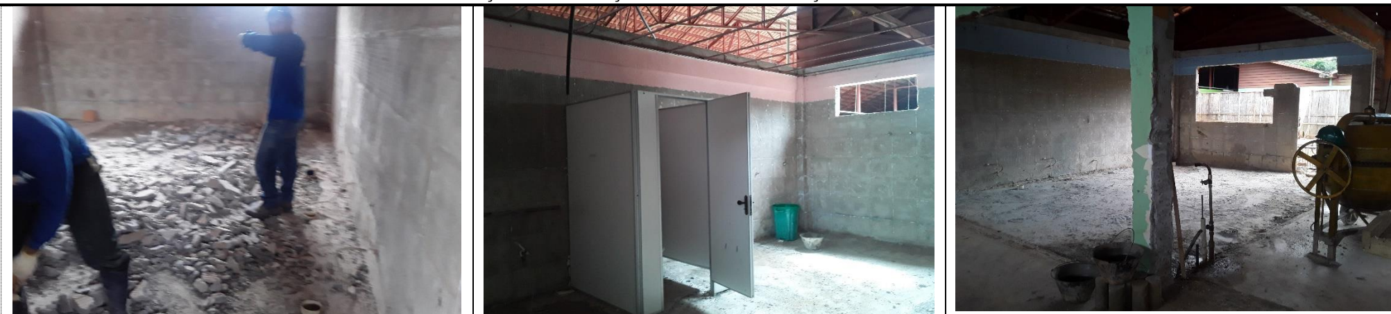
Imagens 25, 26, 27 - Retirada de Aparelhos Sanitários, Retirada de Esquadrias Metálicas, Remoção de Azulejo e Substrato de Aderência em Argamassa, Retirada de Esquadrias de Madeira, Remoção de Divisórias em PVC, Remoção de Bancadas em Granito, Remoção de Cubas de Aço Inoxidável.
