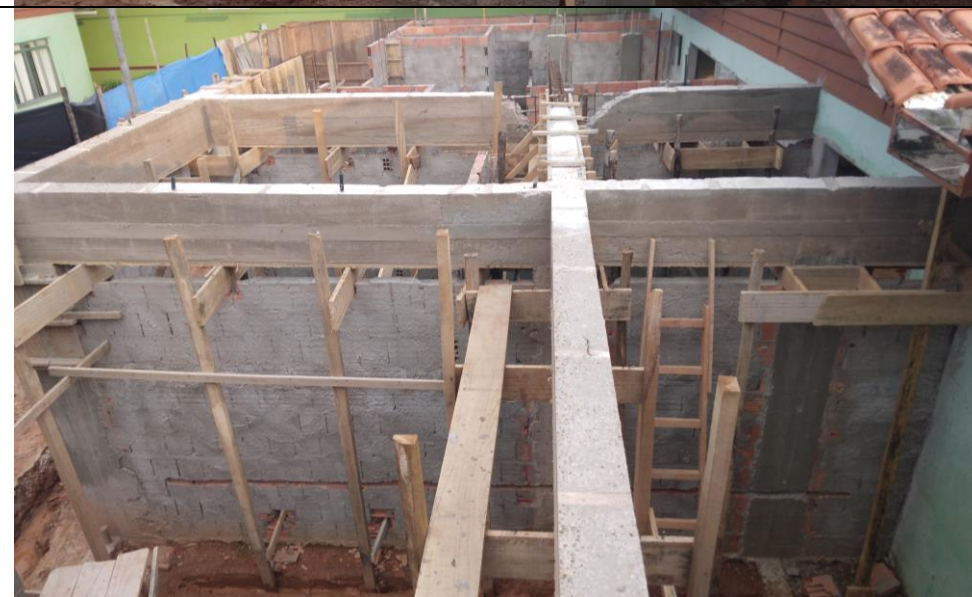
Imagens 55, 56, 57, 58 – Confeção Montagem e Locação de parte dos Aços das Vigas, Confeção e montagem de parte das formas das Vigas, Concretagem das Vigas e parte da desforma das Vigas Concretadas.
