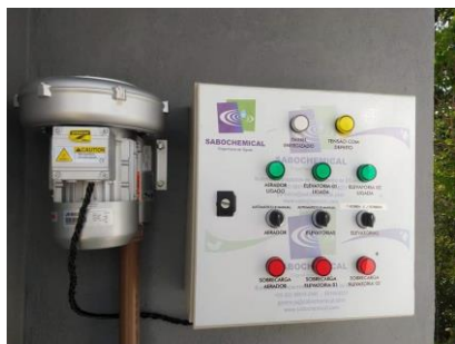
PAINEL ELÉTRICO E SOPRADOR
