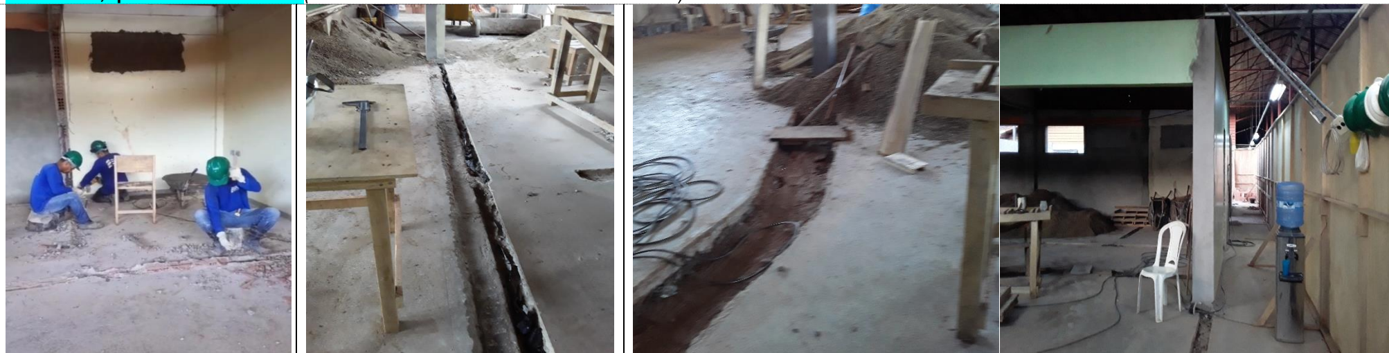
Imagens 18, 19, 20, 21 - Demolição de Piso de Alta Resistência (Lanchonete e WC Masculino)
