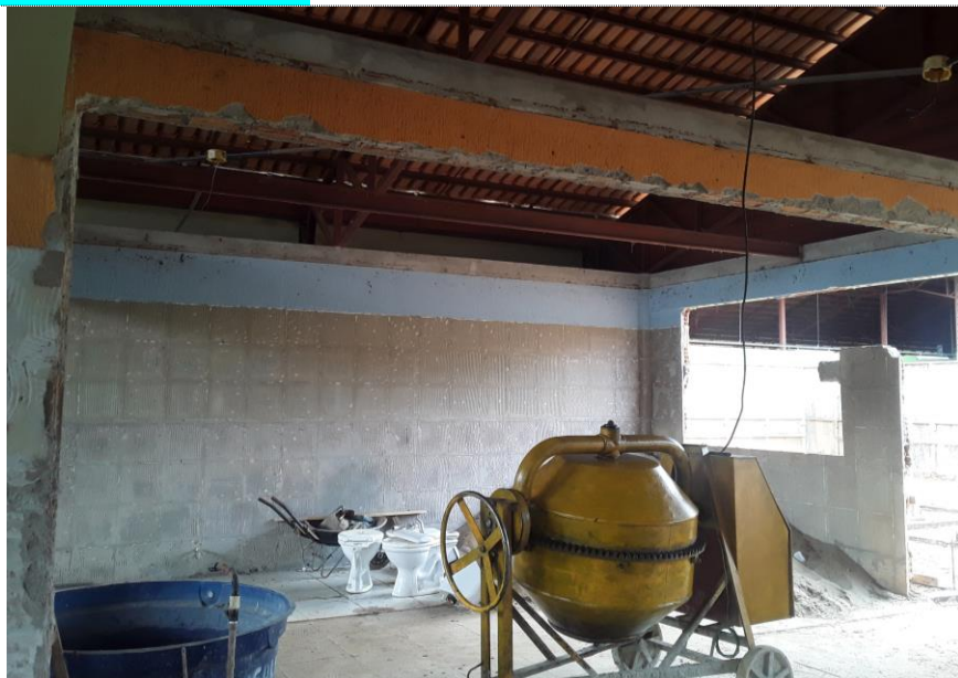
Imagens 12, 13 – Conforme Memória de Cálculo; Retirada de Forro em Reguas de PVC, Inclusive Retirada de Perfis (WC Masculino, Lanchonete e Cozinha).
