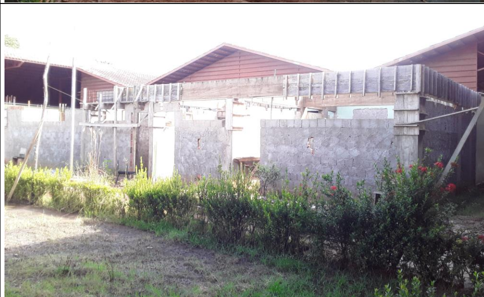
Imagens 55, 56, 57, 58 – Confeção Montagem e Locação de parte dos Aços das Vigas, Confeção e montagem de parte das formas das Vigas, Concretagem das Vigas e parte da desforma das Vigas Concretadas.
