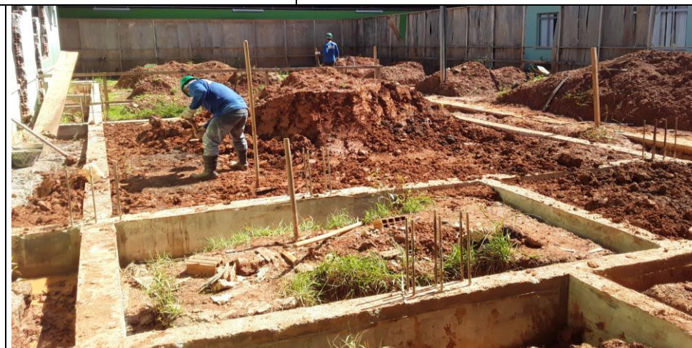
Imagens 42, 43, 44, 45, 46, 47 – Fundação, Escavação das Vigas baldrame, Forma das Vigass, Locação das Ferragem das Vigas Baldrame, Concretagem das Vigas e Desforma das Vigas Baldrame.
