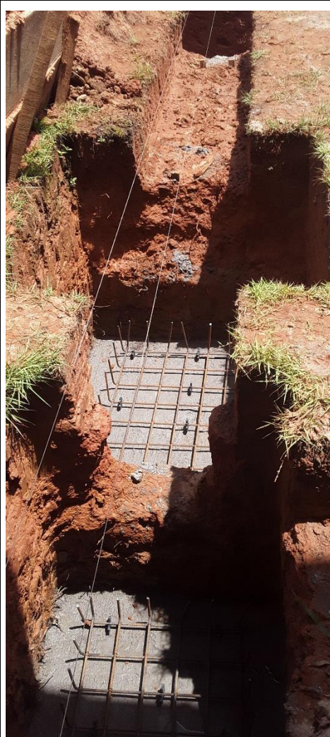
Imagens 33, 34, 35, 36, 37, 38 – Fundação, Escavação das sapatas e Vigas baldrame, Forma das Sapatas, Concreto Magro, Locação das Ferragem das Sapaatas e Arranques dos Pilares, Concretagem das Sapatas.
