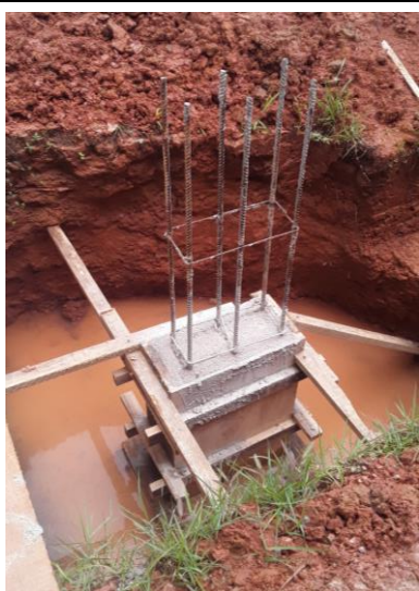
Imagens 39, 40, 41 – Fundação, Escavação das sapatas e Vigas baldrame, Forma das Sapatas, Concreto Magro, Locação das Ferragens das Sapatas e Arranques dos Pilares, Concretagem das Sapatas, Desforma e Compactação das Sapatas.
