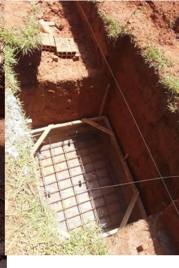
Imagens 33, 34, 35, 36, 37, 38 – Fundação, Escavação das sapatas e Vigas baldrame, Forma das Sapatas, Concreto Magro, Locação das Ferragem das Sapaatas e Arranques dos Pilares, Concretagem das Sapatas.
