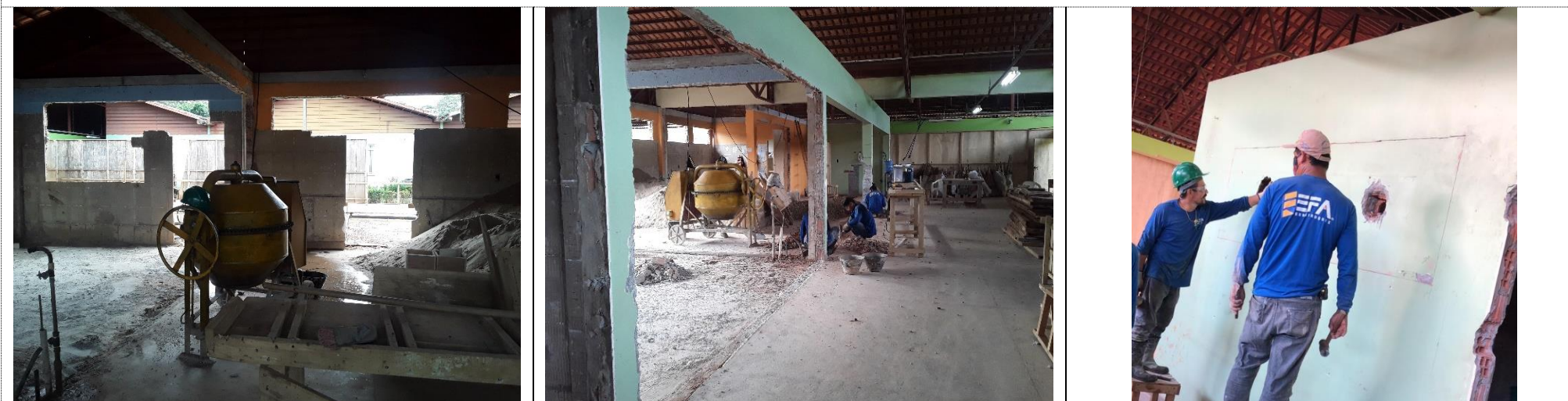
Imagens 28, 29, 30 - Retirada de Aparelhos Sanitários, Retirada de Esquadrias Metálicas, Remoção de Azulejo e Substrato de Aderência em Argamassa, Retirada de Esquadrias de Madeira, Remoção de Divisórias em PVC, Remoção de Bancadas em Granito, Remoção de Cubas de Aço Inoxidável.
