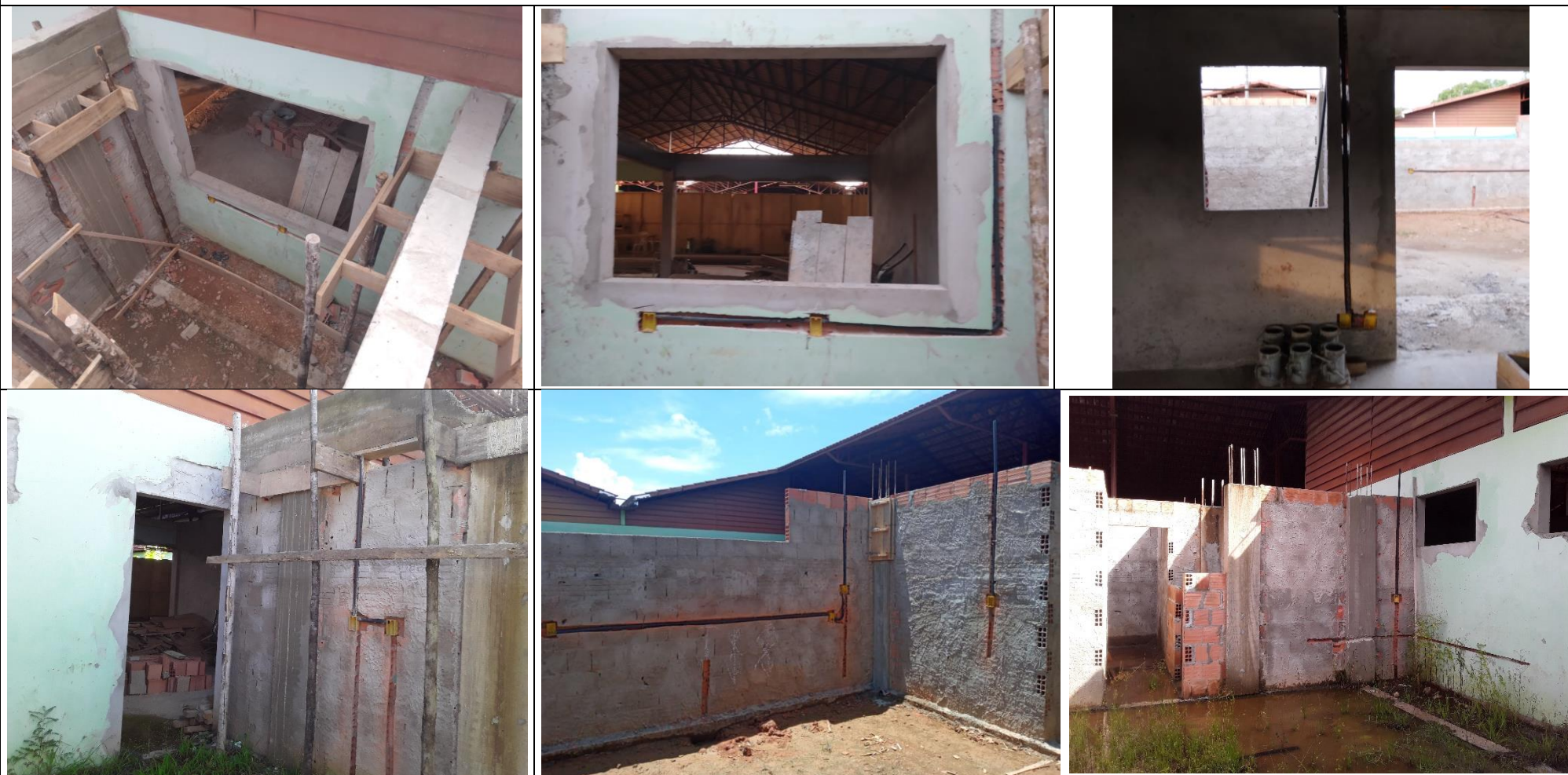
Imagens 84, 85, 86, 87, 88, 89 – Rasgo em Alvenaria para Eletrodutos.
