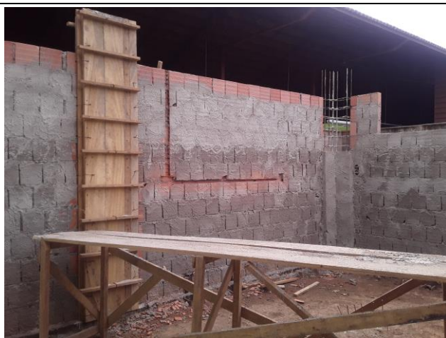
Imagens 48, 49, 50 – Confecção Montagem e locação dos Aços dos Pilares, Confecção e montagem das formas dos pilares, Concretagem e Desforma.
