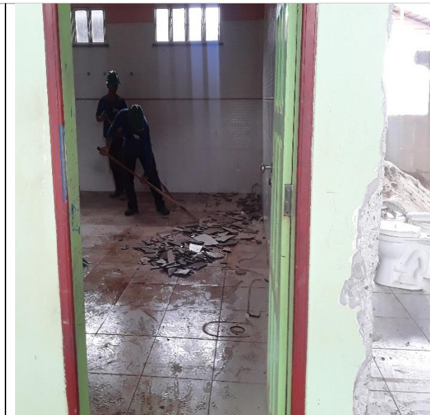
Imagens 22, 23, 24 - Retirada de Aparelhos Sanitários, Retirada de Esquadrias Metálicas, Remoção de Azulejo e Substrato de Aderência em Argamassa, Retirada de Esquadrias de Madeira, Remoção de Divisórias em PVC, Remoção de Bancadas em Granito, Remoção de Cubas de Aço Inoxidável.
