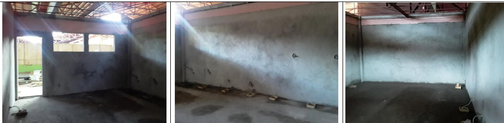
Imagens 72, 73, 74 – Emboço das paredes internas do Ambiente W.C. Feminino
