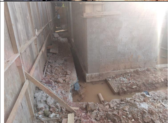
Imagens 78, 79, 80, 81, 82, 83 – Rasgo em Contrapiso para Ramais/ Distribuição e Escavação Manual De Valas
