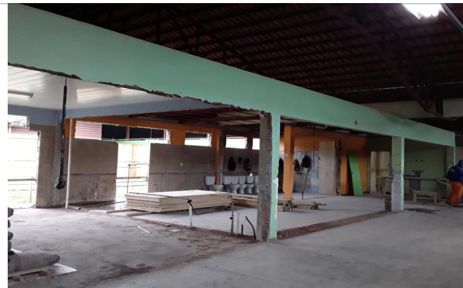
Imagens 10, 11 - Data: 21/10/2020 – Conforme Memória de Cálculo; Demolição de Alvenaria (Lanchonete e WC Masculino)
