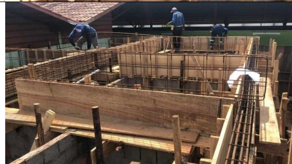
Imagens 51, 52, 53, 54 – Confeção Montagem e Locação de parte dos Aços das Vigas, Confeção e montagem de parte das formas das Vigas.
