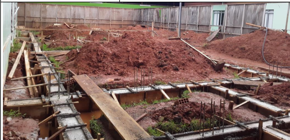
Imagens 42, 43, 44, 45, 46, 47 – Fundação, Escavação das Vigas baldrame, Forma das Vigass, Locação das Ferragem das Vigas Baldrame, Concretagem das Vigas e Desforma das Vigas Baldrame.
