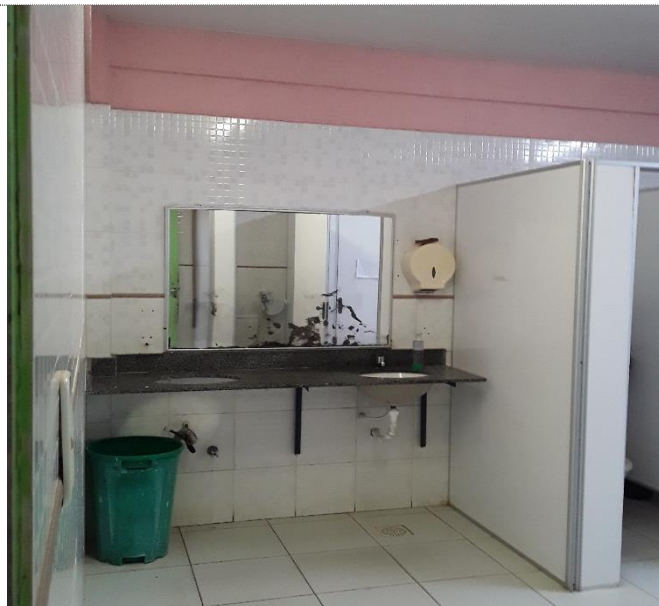
Imagens 22, 23, 24 - Retirada de Aparelhos Sanitários, Retirada de Esquadrias Metálicas, Remoção de Azulejo e Substrato de Aderência em Argamassa, Retirada de Esquadrias de Madeira, Remoção de Divisórias em PVC, Remoção de Bancadas em Granito, Remoção de Cubas de Aço Inoxidável.
