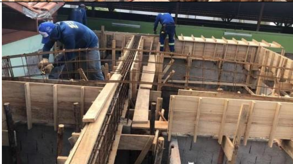
Imagens 51, 52, 53, 54 – Confeção Montagem e Locação de parte dos Aços das Vigas, Confeção e montagem de parte das formas das Vigas.
