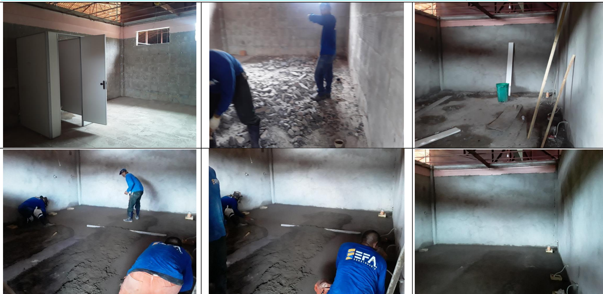
Imagens 66, 67, 68, 69, 70, 71 – Proteção Mecânica de Superfície com Argamassa de Cimento e Areia (Ambiente W.C. Feminino).
