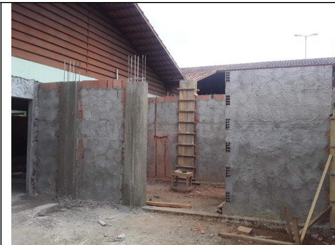
Imagens 48, 49, 50 – Confecção Montagem e locação dos Aços dos Pilares, Confecção e montagem das formas dos pilares, Concretagem e Desforma.
