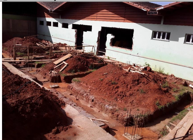
Imagens 39, 40, 41 – Fundação, Escavação das sapatas e Vigas baldrame, Forma das Sapatas, Concreto Magro, Locação das Ferragens das Sapatas e Arranques dos Pilares, Concretagem das Sapatas, Desforma e Compactação das Sapatas.
