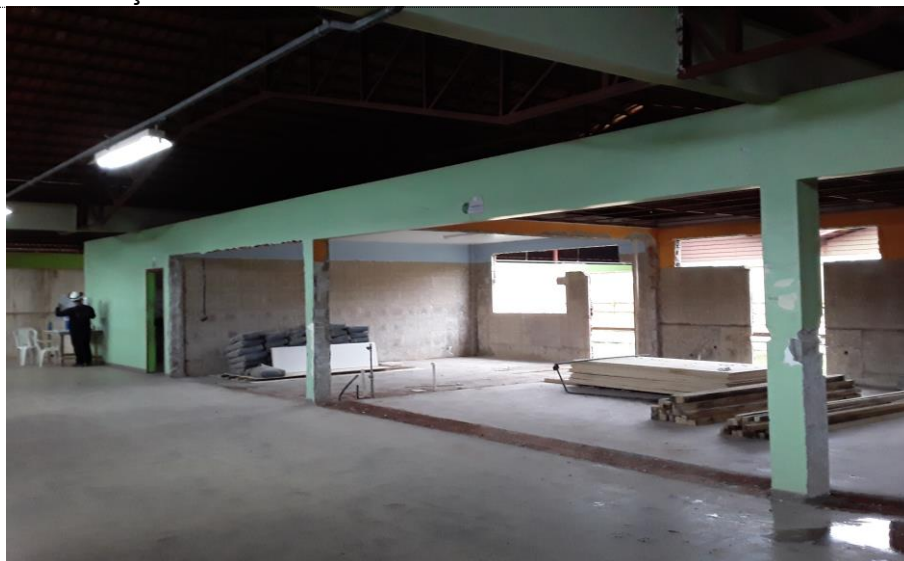
Imagens 10, 11 - Data: 21/10/2020 – Conforme Memória de Cálculo; Demolição de Alvenaria (Lanchonete e WC Masculino)
