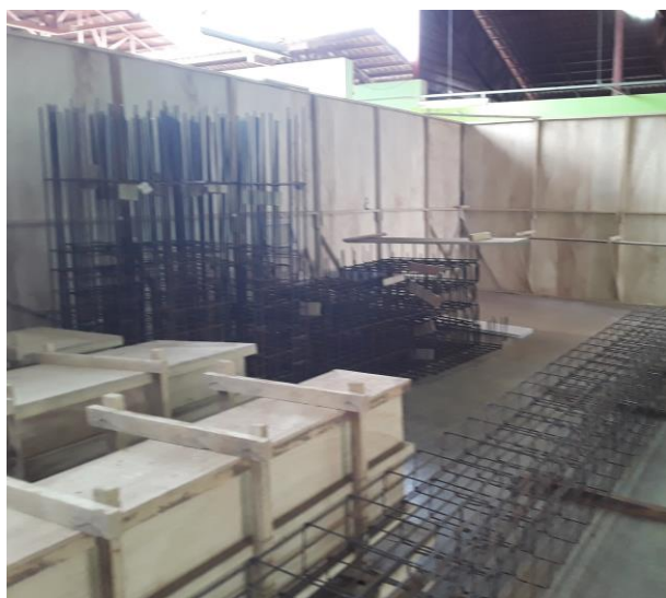
Imagens 33, 34, 35, 36, 37, 38 – Fundação, Escavação das sapatas e Vigas baldrame, Forma das Sapatas, Concreto Magro, Locação das Ferragem das Sapaatas e Arranques dos Pilares, Concretagem das Sapatas.
