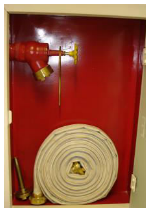
Figura 6 – armário de hidrantes com mangueiras
