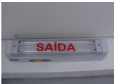
Figura 4 – Iluminação de emergência
