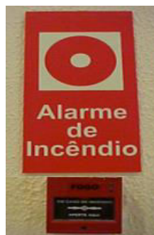
Figura 2: Botão de alarme de incêndio
