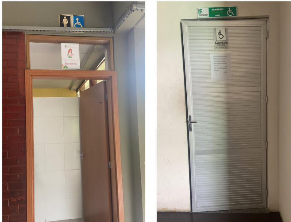
Figura 14 – Acessibilidade aos banheiros (substituição das portas).
