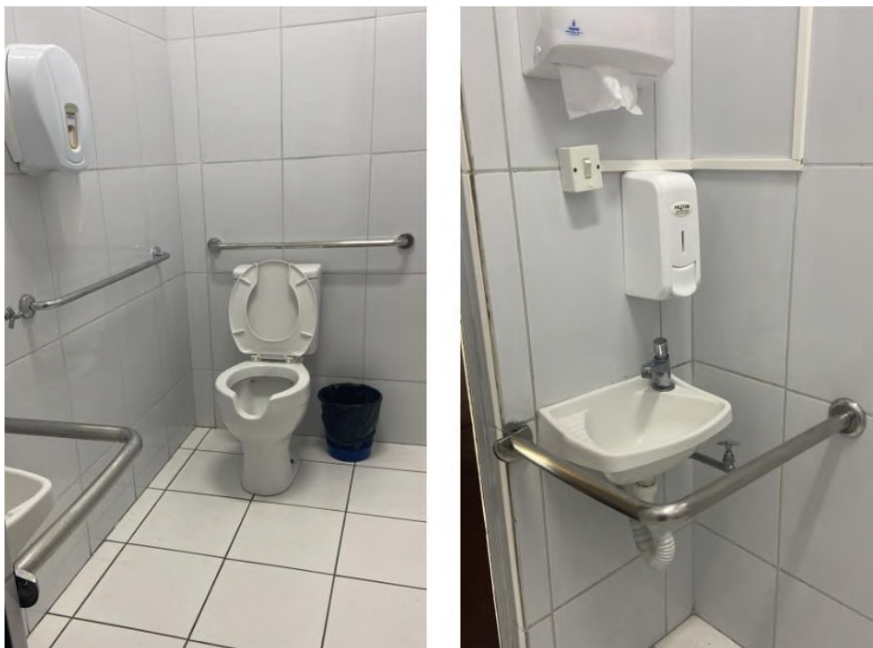
Figura 15 – Acessibilidade aos banheiros (substituição das portas).
