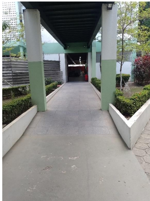
Figura 12 - Rampa de acesso do Bloco administrativo – Do Térreo para o CDI
