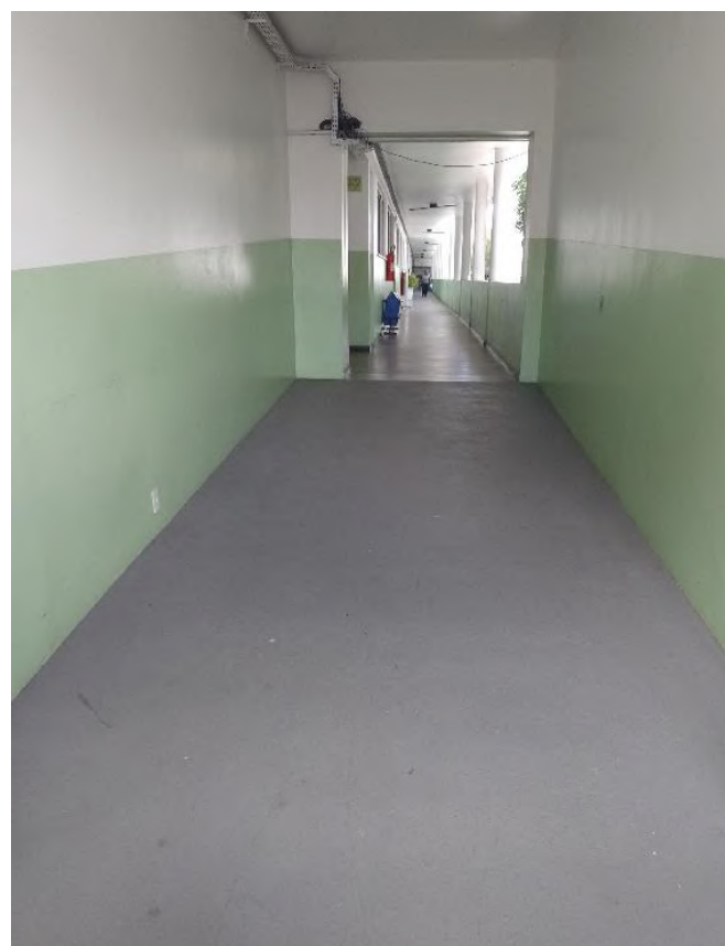
Figura 10 - Rampa de acesso ao Bloco administrativo – 1º Pavimento.
