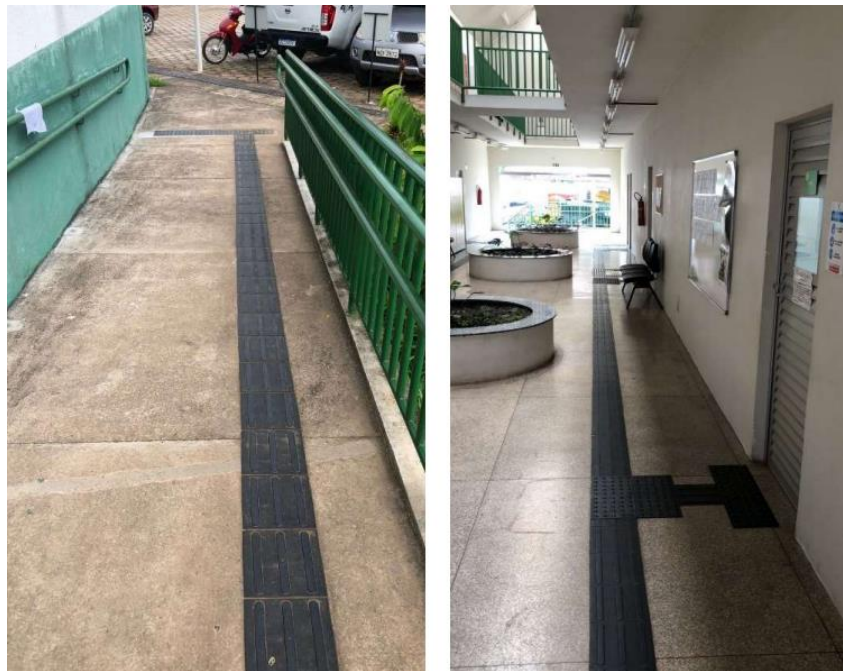
Figura 19 - Piso podotátil instalado em áreas externas e internas do campus.
