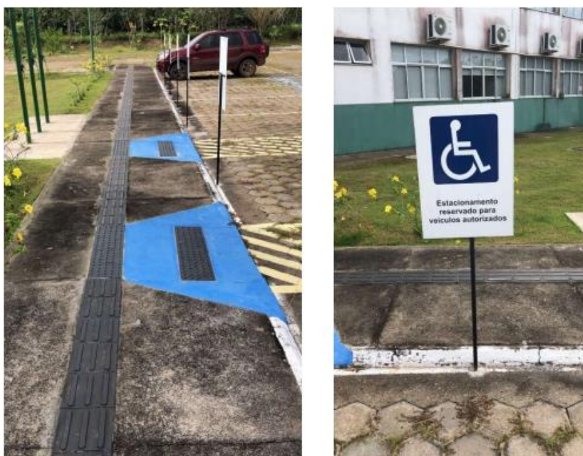
Figura 20 – Rampas de acesso e vagas de estacionamento reservadas.
