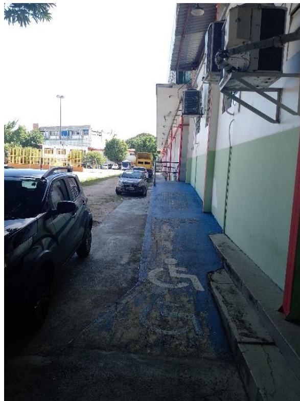
Figura 8 - Rampa de acesso ao Centro de Artes.
