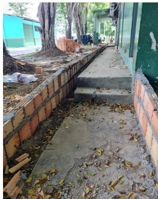
Figura 17 – Construção de Rampas de acesso às edificações.
