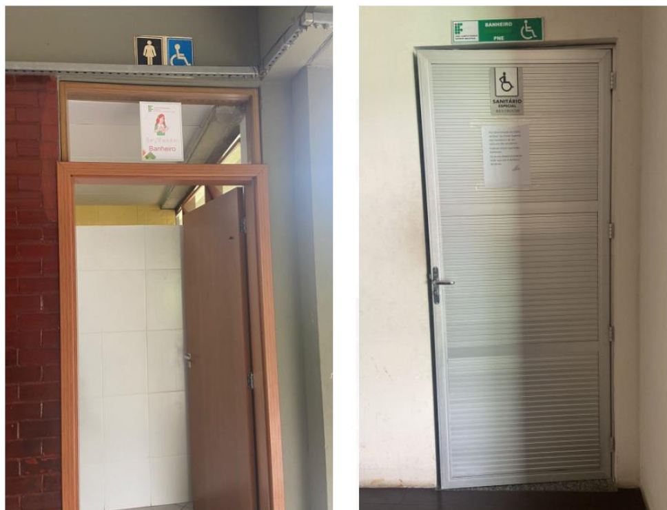
Figura 14 – Acessibilidade aos banheiros (substituição das portas).
