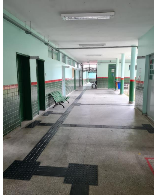
Figura 16 – Piso Podotátil instalado em áreas internas do campus.
