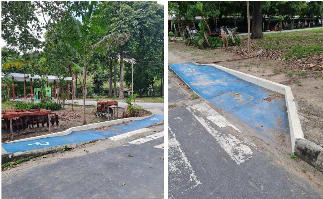
Figura 18 – Rampas de acesso às calçadas.
