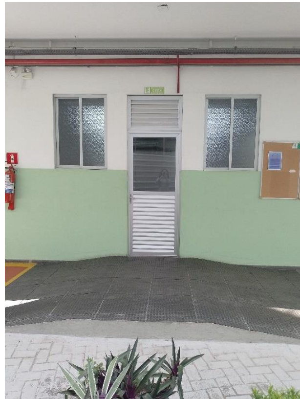
Figura 6 - Rampa no Bloco Administrativo - Pavimento Térreo
