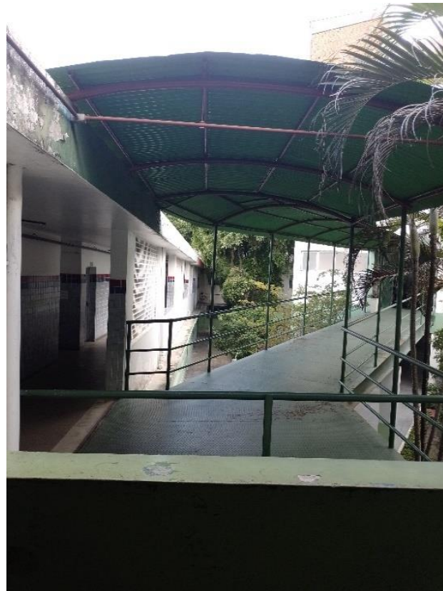
Figura 3 - Rampa de ligação entre o bloco de salas de aula e o 1º pavimento do CDI.
