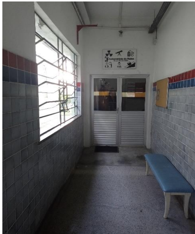
Figura 9 - Rampa de acesso aos Laboratórios de Física.
