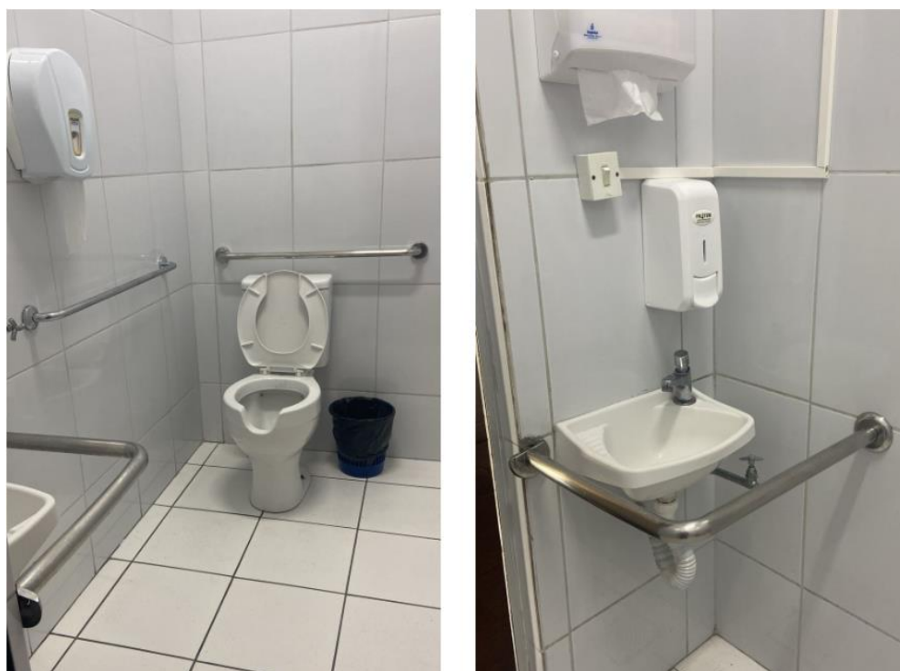
Figura 15 – Acessibilidade aos banheiros (substituição das portas).
