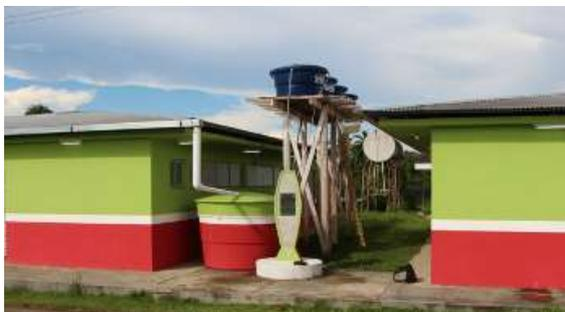
**Figura 1:** Modelo integrado de captação e abastecimento da água pluvial com a utilização da energia fotovoltaica da residência estudantil do Instituto Federal do Amazonas – IFAM, *Campus* São Gabriel da Cachoeira – AM.
