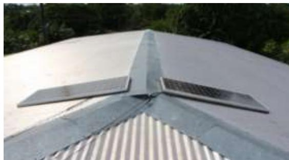
**Figura 2:** Posição dos painéis fotovoltaicos na superfície do telhado da residência estudantil do Instituto Federal do Amazonas – IFAM, *Campus* São Gabriel da Cachoeira – AM.
