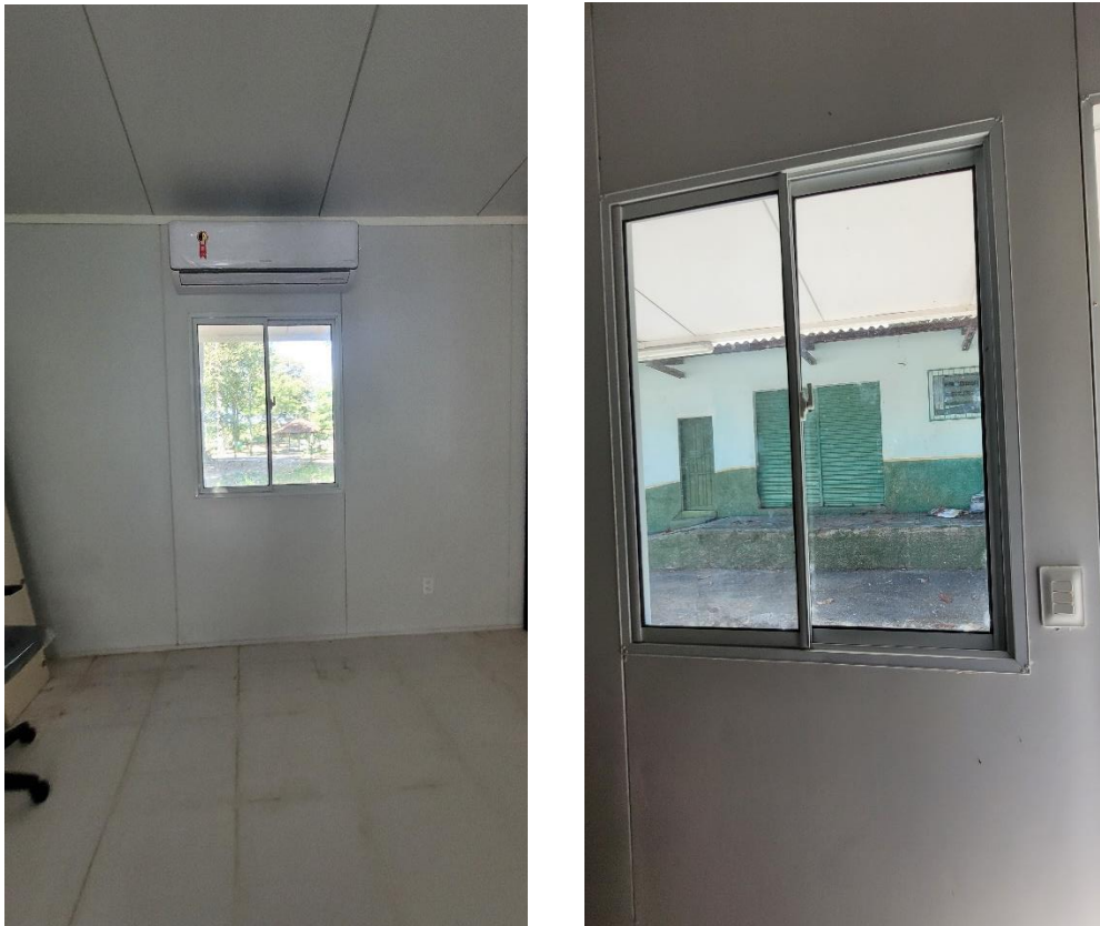
Centro de Distribuição Localizado no Campus Manaus Zona Leste – Vista Interna
