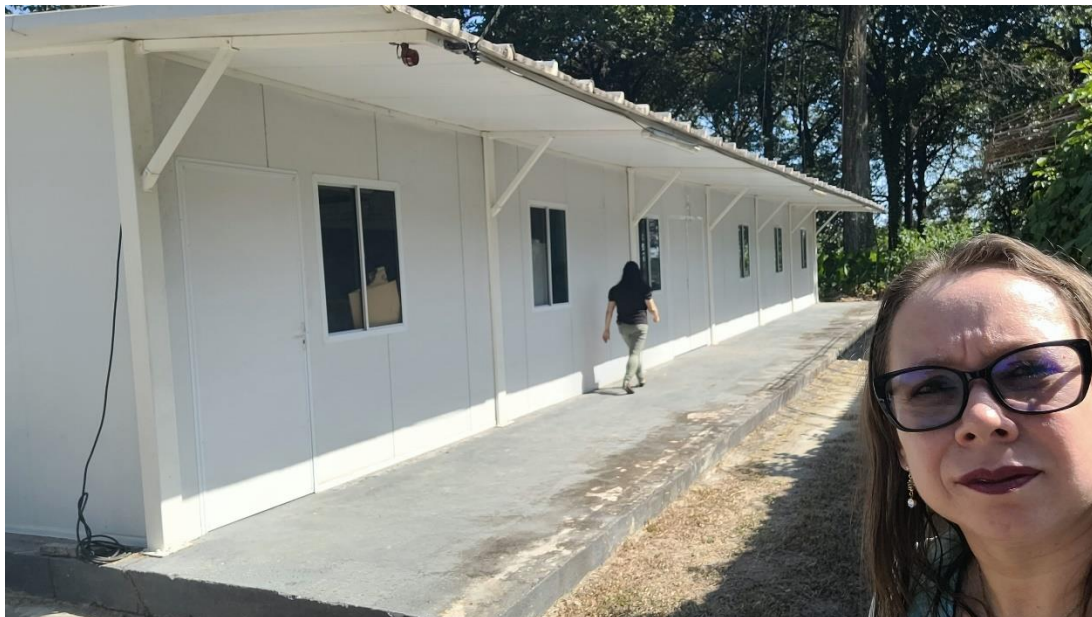
Centro de Distribuição Localizado no Campus Manaus Zona Leste – Vista Externa
